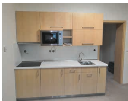
Instalace kuchyňské linky
